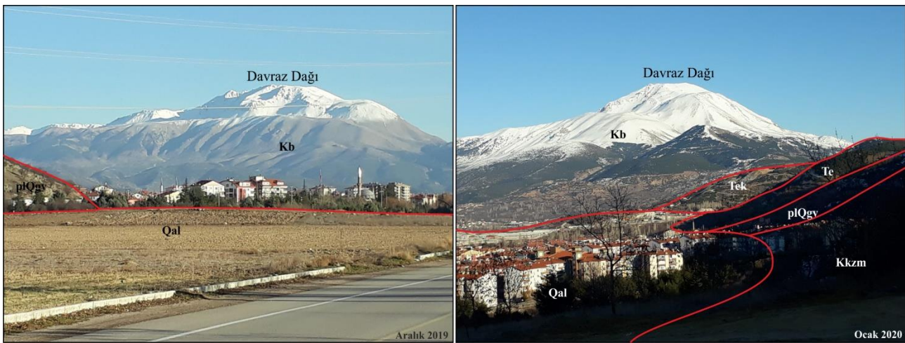
Şekil 4. Davraz Dağı'ndan (Isparta) görünüm (a) Kuzeybatıdan bakış, (b) Güneybatıdan bakış (Kb: Beydağları formasyonu, Tek: Küçükköy formasyonu, Te: Elmalı formasyonu, Kkzm: Kızılcadağ melanj ve olistostromu, plQgv: Gölcük formasyonu volkanit üyesi, Qal: Alüvyon) (Views of Davraz Mountain (Isparta) (a) View from the northwest, (b) View from the southwest (Kb: Beydağları formation, Tek: Küçükköy formation, Te: Elmalı formation, Kkzm: Kızılcadağ melange and olistostrome, plQgv: Gölcük formation volcanite member, Qal: Alluvium))
