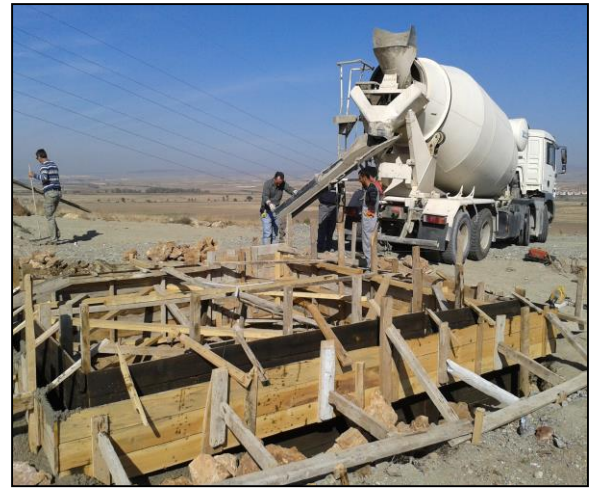
Şekil 7. Betonlama Çalışmaları Gösterimi
