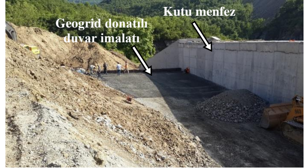
Şekil 9. Geogrid donatılı istinat duvarının başlangıç aşaması (Initial stage of geogrid-reinforced retaining wall)
