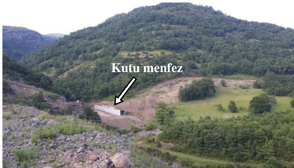
Şekil 8. Kutu menfezin kısmen tamamlanmış görüntüsü (A view of the partially completed box culvert)
