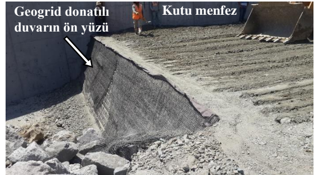
Şekil 10. Geogrid donatılı istinat duvar imalatının ileri bir aşaması (An onward construction stage of the geogrid reinforced retaining wall)
