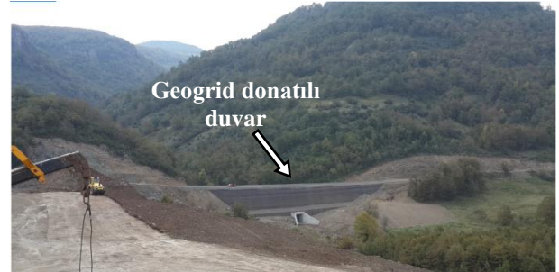
Şekil 11. Geogrid donatılı istinat duvarının tamamlanmış halinden bir görünüm (A view of the completed stage of the geogrid reinforced retaining wall)
