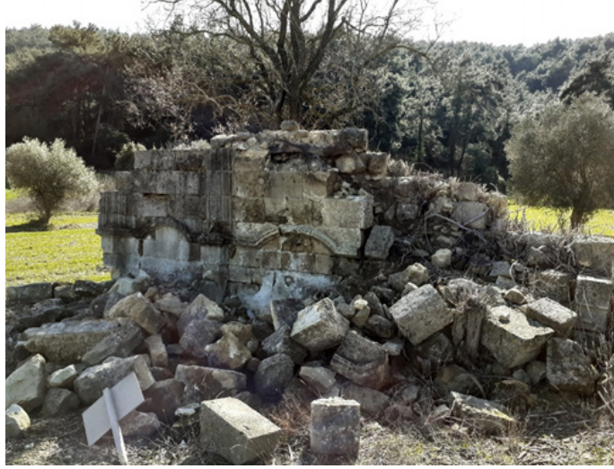
Res.4- Cevat Paşa Çeşmesi (2022)
