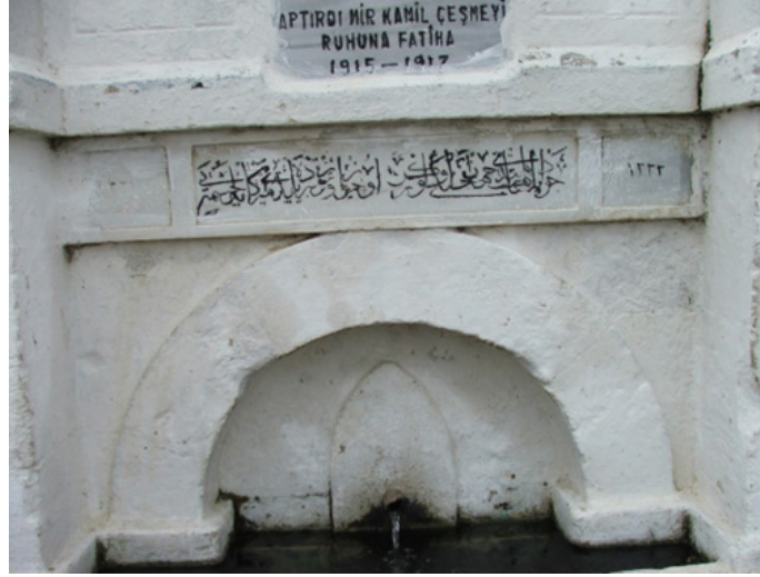
Res.15- Sarıcaeli Cevat Paşa Çeşmesi cephe detayı (2007)
