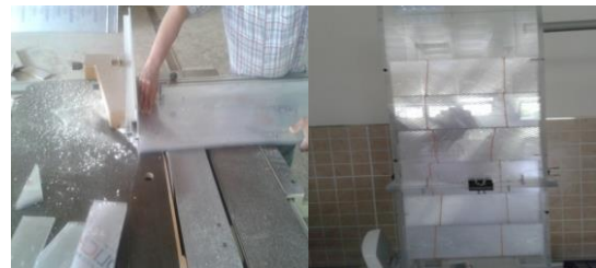
Şekil 2. Polikarbonat levhaların hazırlanması ve kolonlara yerleştirilmesi
