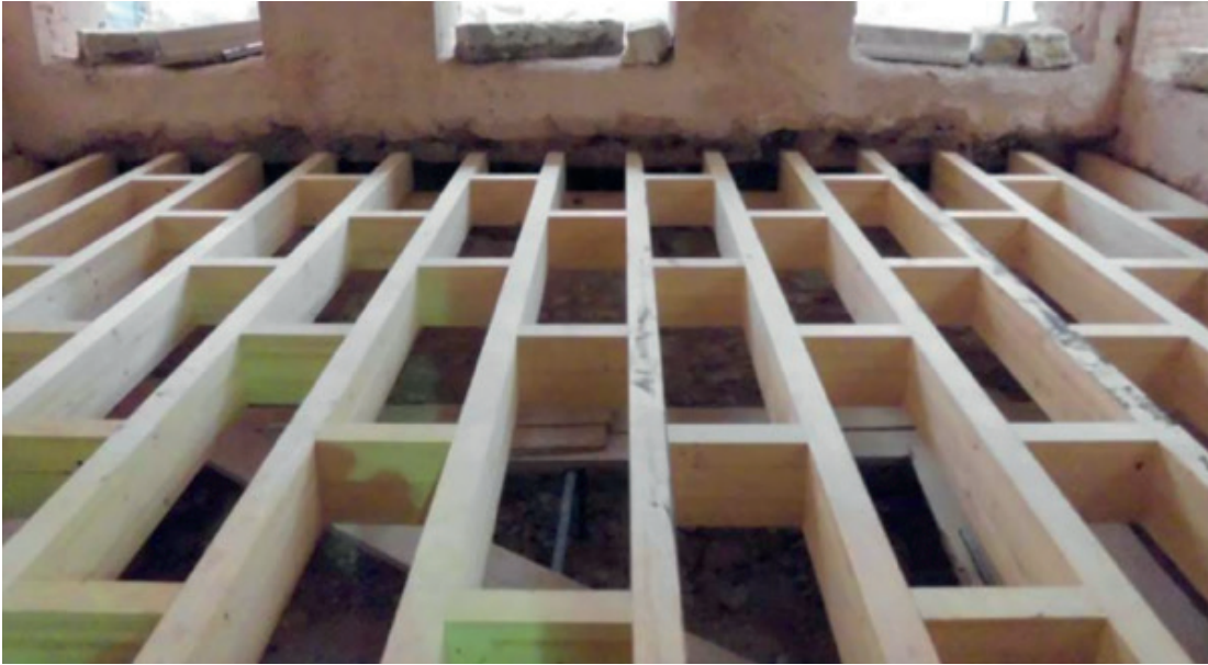
Resim 6. Büyük Mecidiye Cami Hünkar Kasrındaki ahşap zemin uygulaması (Ersen ve Timas Koçak, 2014)
