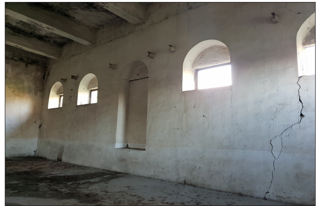
Fotoğraf 7. Ambar-2 doğu duvarı / The east wall of the Warehouse-2.
