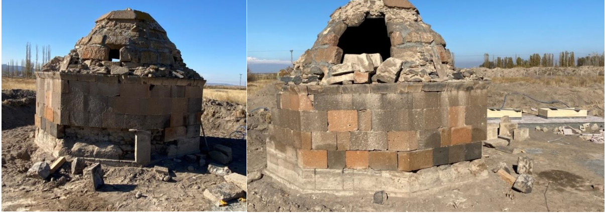
Res. 17-18: Kolikent Kumbeti Çevre Düzenleme Onarım Görünüşleri (Ş. Öztürk-2021)
