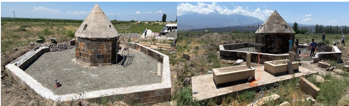
Res. 19-20: Kolikent Kumbeti Çevre Düzenleme Onarım Görünüşleri (Ş. Öztürk-2021)
