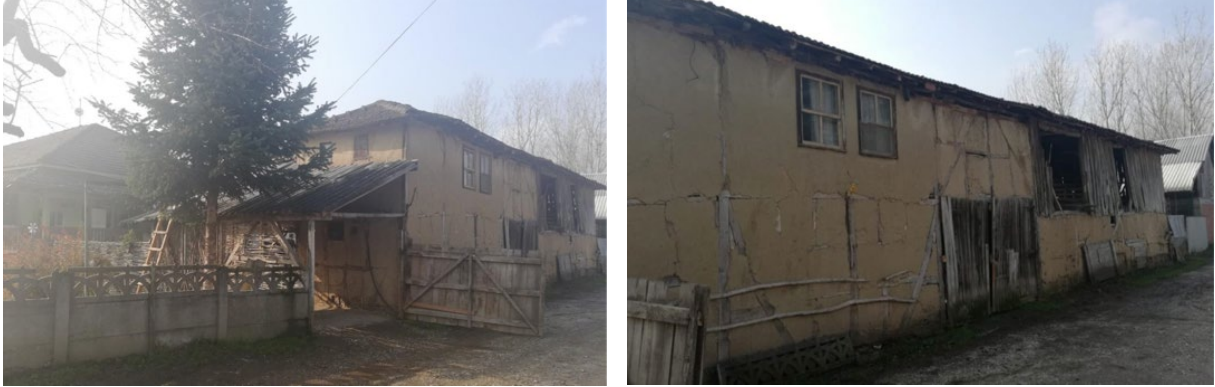
Şekil 19. Haçes avlusuna giriş, solda ana konut sağda haçes ve kuruluk (sol), haçes ve kuruluğun sokak cephesinden görünüşü (sağ).
