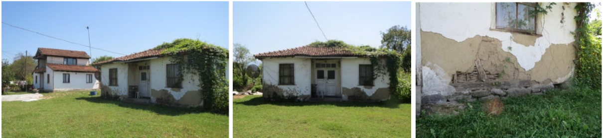
Şekil 34. Solda ana konut, sağda haçeş (sol), haçeş ön cephe görünüşü (orta), sıvası dökülmüş bölgelerde gözlemlenen dal örme tekniği (sağ).
