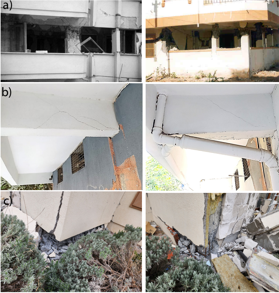
Şekil 4. Düzensizliklerden kaynaklanan hasarlar; a) Kısa kolon etkisi, b) Ağır çıkma, c) Burulma kaynaklı dış aks kolon hasarı
