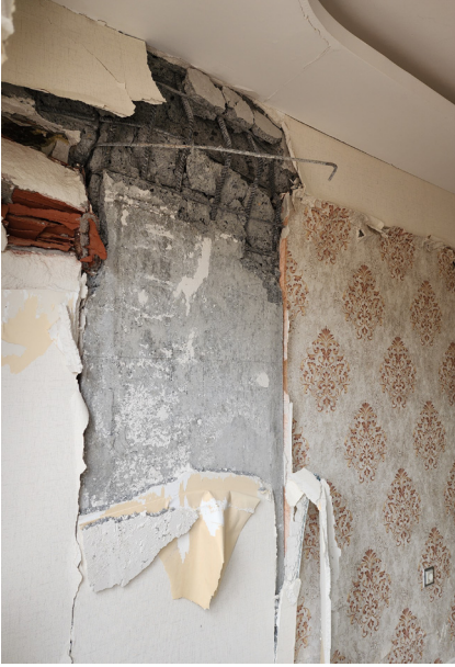
Şekil 5. Yetersiz malzeme ve donatı nedeniyle oluşan kolon hasarı
