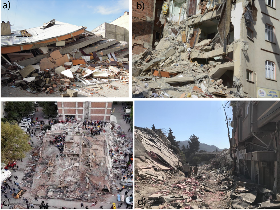
Şekil 2. Toptan göçen binalar; a) 2011 Van depremi, b) 2020 Elazığ depremi, c) 2020 İzmir depremi, d) 2023 Kahramanmaraş depremleri
