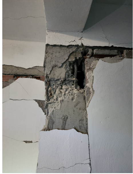
Şekil 5. Yetersiz malzeme ve donatı nedeniyle oluşan kolon hasarı
