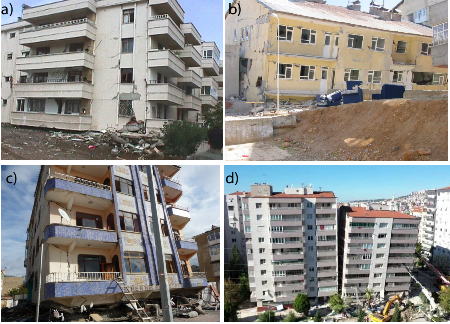
Şekil 1. Geçmiş depremlerde gözlenen yumuşak/zayıf kat hasarları; a) 1999 Kocaeli depremi, b) 2003 Bingöl depremi, c) 2011 Van depremi, d) 2020 İzmir depremi
