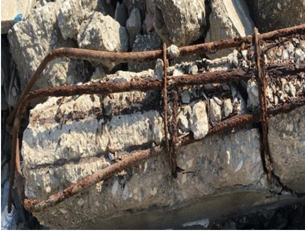
Şekil 7. Korozyona uğramış donatı
