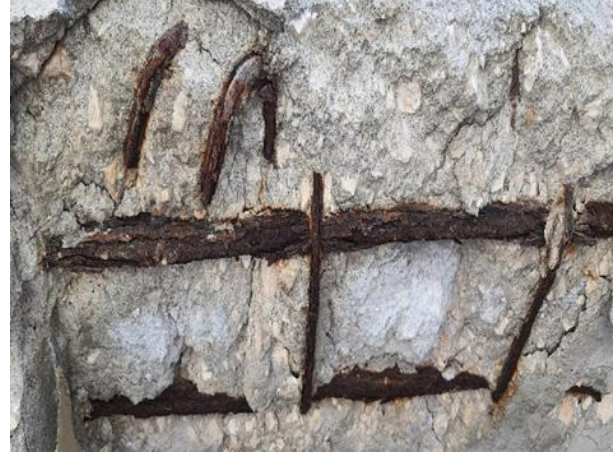
Şekil 7. Korozyona uğramış donatı
