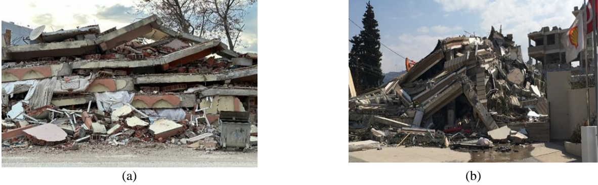
Şekil 9. Yumuşak kat düzensizliğinden dolayı toptan göçme meydana gelen yapılar. a) Hatay-Antakya, b) Hatay-Samandağ
