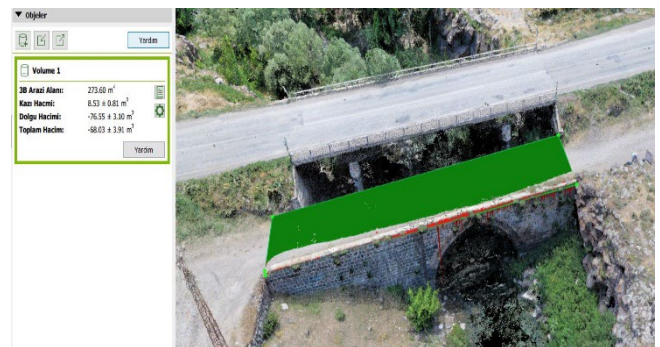
Şekil 2. Hatuniye köprüsünün yüzeyine ait (yeşil işaretli alan) ölçüm değerleri.
