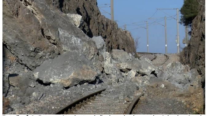
Fotoğraf 4. Deprem oluşturduğu heyelanlar nedeniyle demiryolu hattı ulaşımına kapanmıştır (NTV, 2023).
