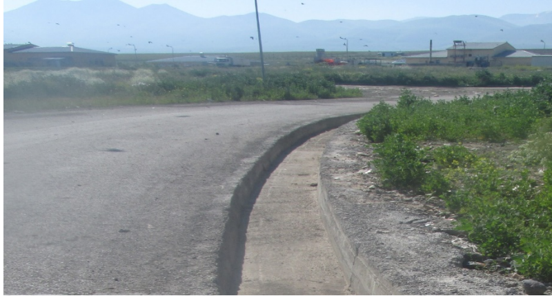
Şekil 3. EKADDT’inde yağmur suyu kanalı görüntüsü
