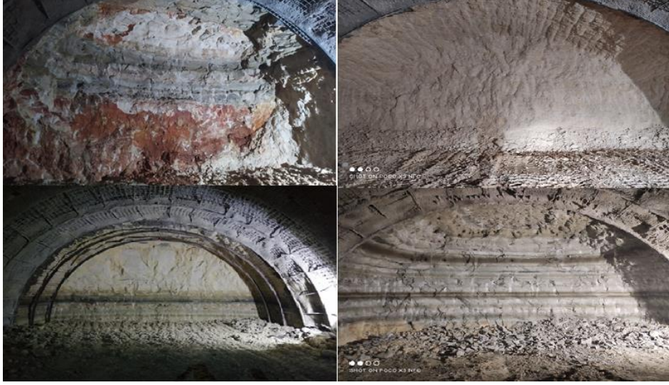
Şekil 5. Tünel güzergâhında bulunan birimlerin tünel içerisindeki görünümü
