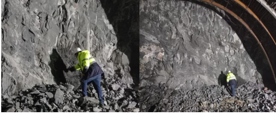
Şekil 6. Tünel içerisindeki süreksizlik özelliklerinin ve aynadaki su durumunun belirlenmesi için yapılan çalışmalardan bir görüntü
