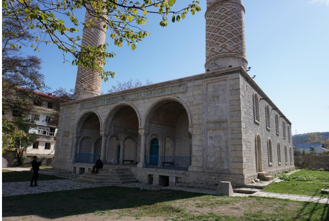
Res.10- Kuzey cepheden görünüm
