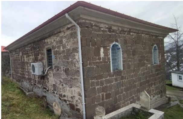
Resim 12. Batı ve güney cephe
