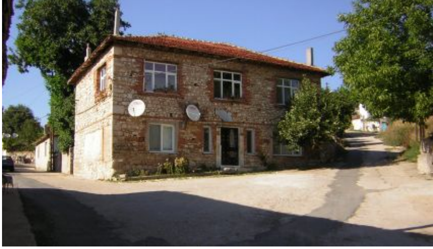
Fotoğraf 8. Taş ve tuğladan yapılmış yığma bir bina (Mimar Sinan Mah.).
