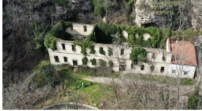
Şekil 1. Tarihi Safranbolu Tabakhane Binasının günümüzdeki durumu.
