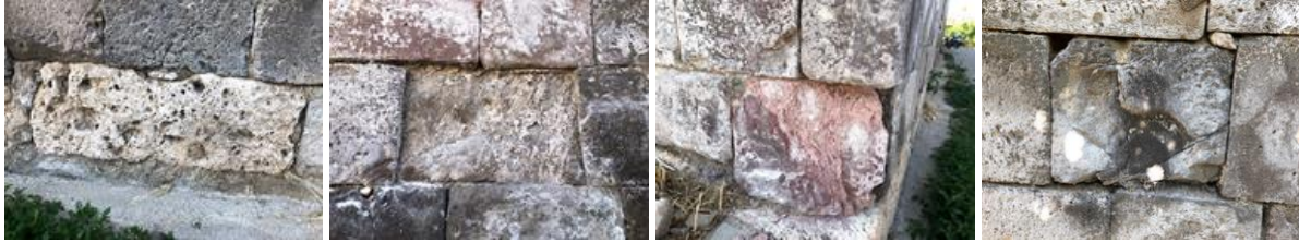
Şekil 19. Taş Bozulmalarından Örnekler; soldan sağa Oyuklanma (Alveol) Oluşumu, Ayrışma, Renk Değişimi ve Ayrışma, Tuzlanma ve Ayrışma, 2019
