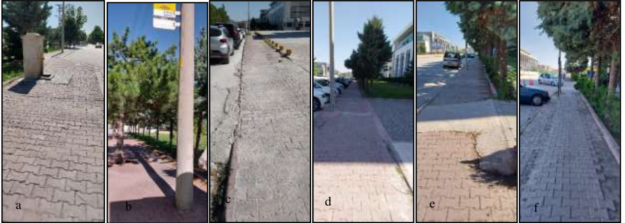
Şekil 25. B2 Güzergahının genel görünümü (Figure 25. General view of B2 Route)
