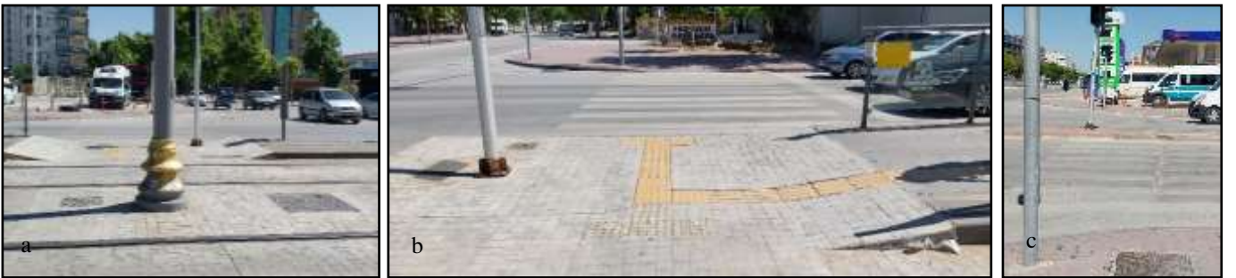
Şekil 7. A1 Bölgesi'nde bulunan yaya geçitlerinin genel görünümü (Figure 7. General view of pedestrian crossings in A1 Region)
