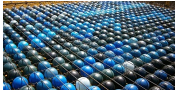
b) Cobiax Eco-Line Cage Modules
