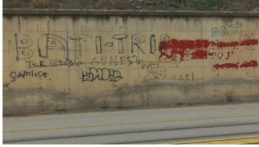
Resim 7. Tek isteğim Güneş’in batıdan doğması. Çamlıca Mah.
