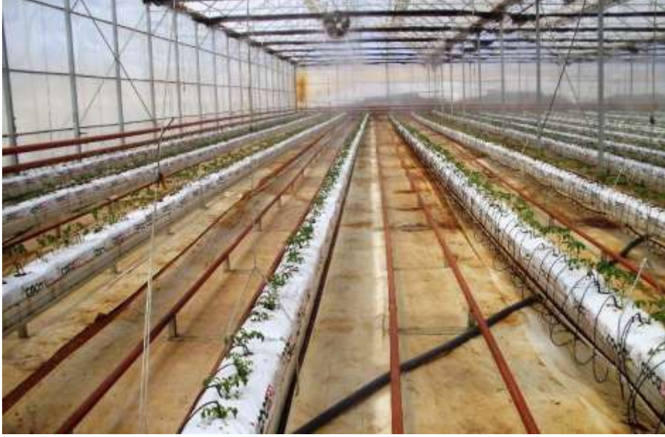
Fotoğraf 3: Sera İçinin Isıtılması Sıralı Olarak Döşenen Borular Yoluyla Gerçekleştirilmektedir
