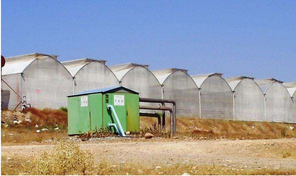
Fotoğraf 6: Seralar Yüksek Tünel Tarzında ve Polikarbon Kullanılarak İnşa Edilmiştir.
