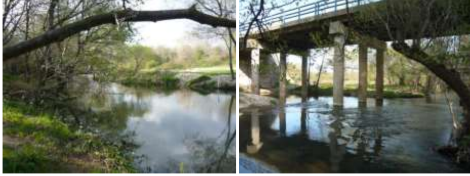
Şekil 12. Karamandere ve Karamandere Köprüsü
