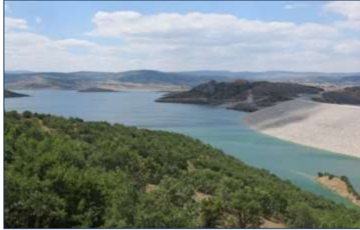
Fotoğraf 2: Çekerek İlçesi yakınlarında inşa edilen Süreyyabey Barajı ve arka planda Çekerek İlçesi
