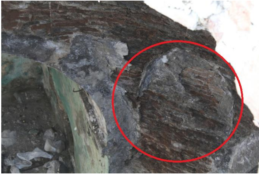
Şekil 9. Yeni Hamam da Sızan sulardan kaynaklı parça kopması
