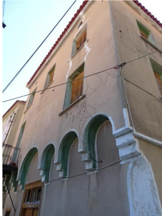
Şekil 15. Semer Tonoz Çıkmalı Ev Örneği (Kişisel Arşiv)
