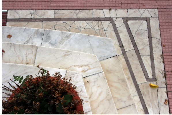
Görsel 24. AÜ GSF Dekanlık Binası Girişi 2023
