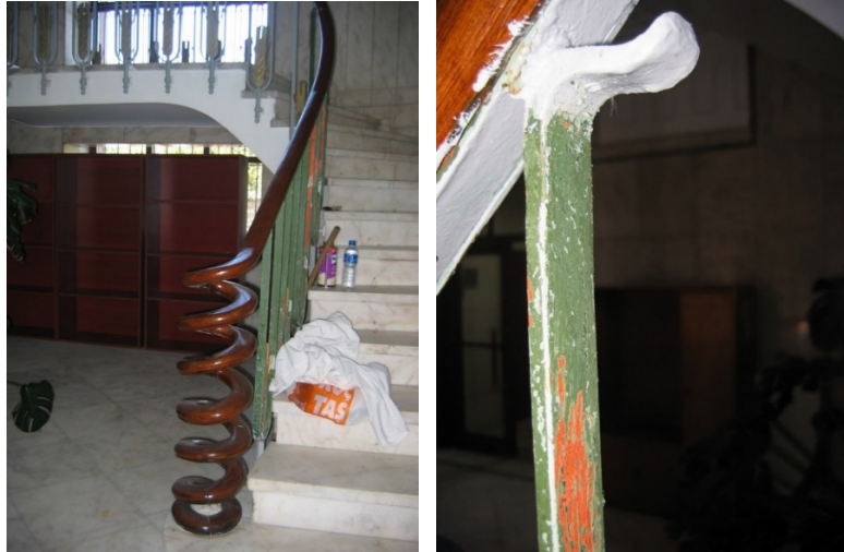
Görsel 21. AÜ GSF Dekanlık Binası Tırabzanlarının Konservasyonu “Metal Koruma ve Onarım Dersi Uygulama Projesi-2014”
