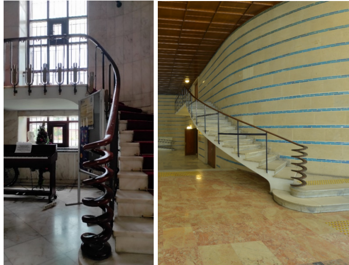
Görsel 18. (Solda) AÜ GSF Dekanlık Binası Merdiven Parmaklıkları, (Sağda) AÜ DTCF Farabi Salonu Balkon Merdiveni Parmaklıkları
