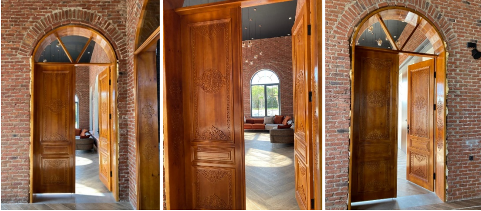
Şekil 18. İç mekan kapıları.
