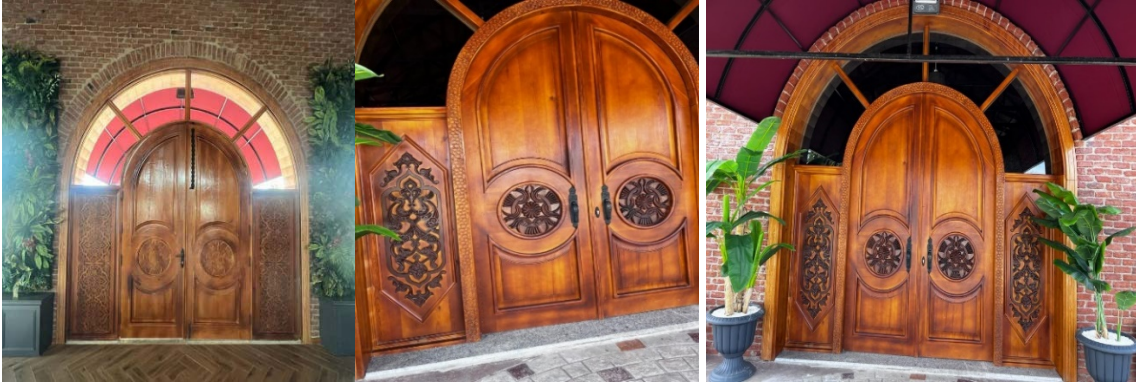
Şekil 17. Ahşap ana taç kapı arka ve ön görünümü.
