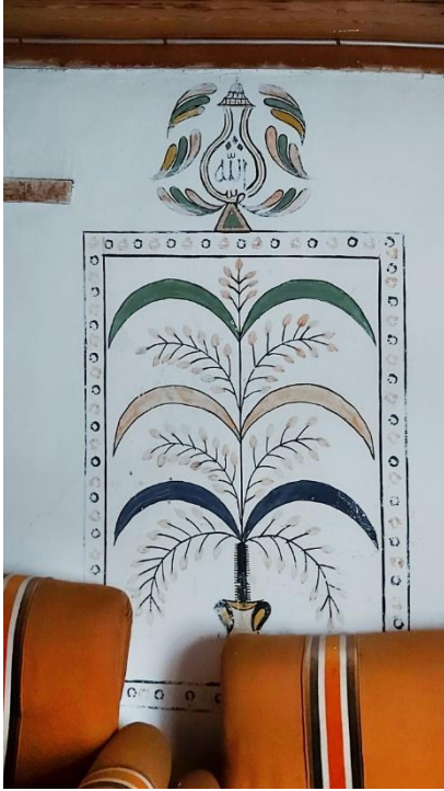
Fotoğraf 4. Üst kat sofa güney duvarındaki kalem işleri
