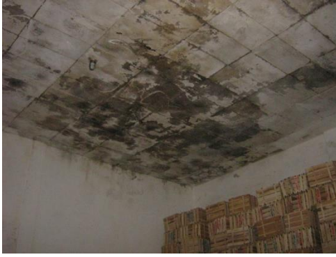
Şekil 4. EPS malzemesinde meydana gelen kararma ve deformasyonlar Figure 4. Darkening and deformations occurring in EPS material
