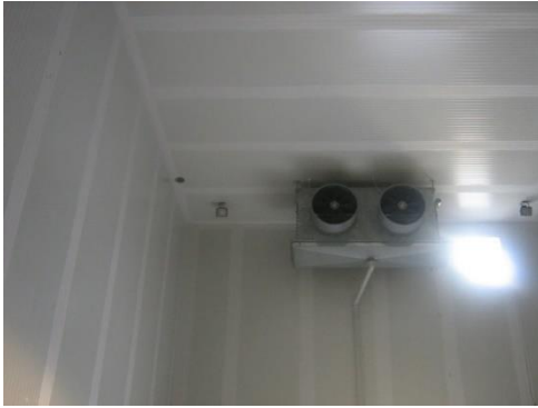
Şekil 6. Herhangi bir kararma ve deformasyon yapmayan PU panel malzemesi Figure 6. PU panel material that does not make any darkening and deformation
