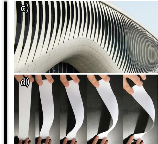
Şekil 10. Thematic Pavilion Expo 2012 (a) cephenin genel görünümü, (b) cephenin çalışma konsepti (Kaynak: (c) (URL-8), (d) Knippers vd., 2012)
