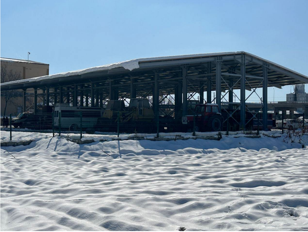
Şekil 16: Tek katlı çelik çerçeve (çatı) sistemi (38.351488° K, 38.275932°D) Figure 16: Single-story steel frame (roof) system (38.351488° N, 38.275932°E)
