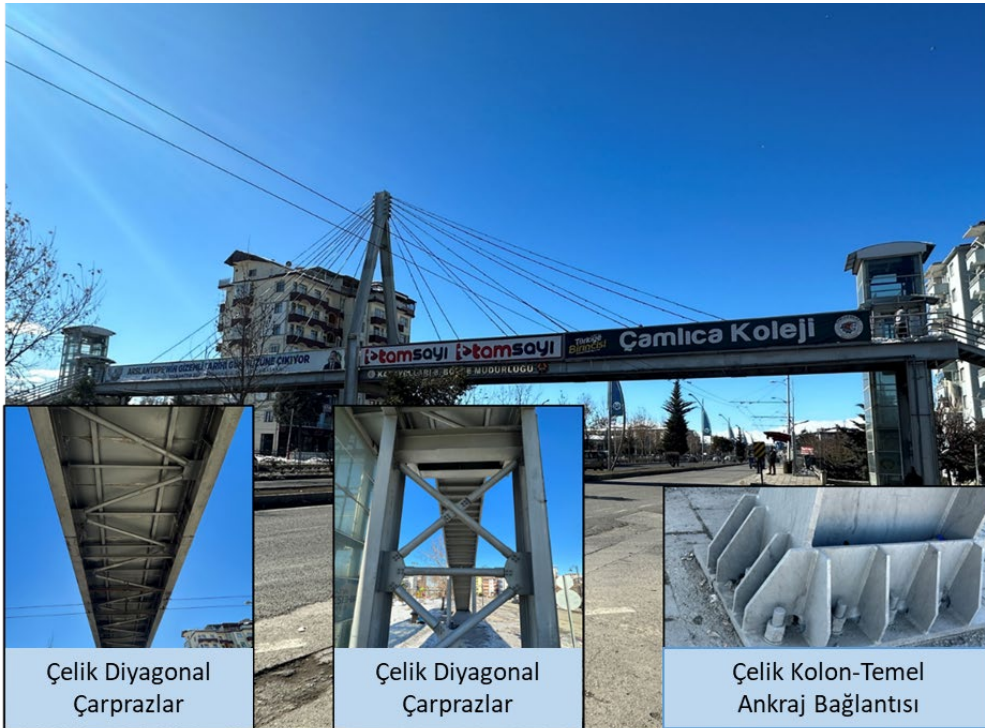
Şekil 18: Ayrıntılı bağlantı parçalarıyla birlikte asma yaya köprüsünün boyuna profili (38.350430° K, 38.292798° D)
