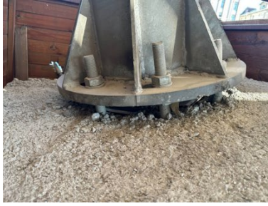
Şekil 20: Şemsiye şeklindeki modelin bağlantı parçalarının detaylı gösterimi a) Kolon-ankraj rotu bağlantısı b) Kiriş-kiriş bulonlu bağlantısı c) Kafes kiriş sistem bağlantısı
