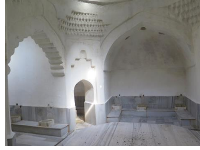
Fig. 18. Antalya Nazır Hamamının Sıcaklık Merkez Kubbesinin Geçiş Sistemi
