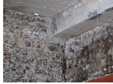
Fig. 32. Antalya Nazır Hamamının Kuzeydoğu Köşesindeki Sur Duvarının Taş Örgüsü
