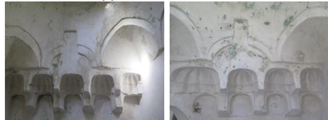
Fig. 23-24. Antalya Nazır Hamamının Kuzeybatı Halvet Hücresindeki Mukarnas Şeklinde Sarkıklar
