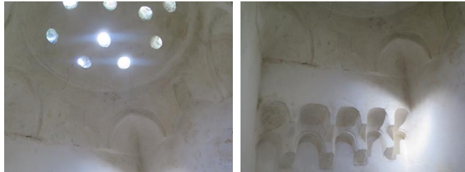
Fig. 21-22. Antalya Nazır Hamamı Halvet Hücreleri Kubbe Geçiş ve Duvarlardaki Sarkıklar
