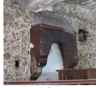
Fig. 10-11. Nazır hamamı Ilıklığa Geçiş Kapısı ve Üzerindeki Davlumbaz
