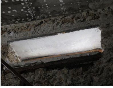
Fig. 9. Nazır Hamamı Soyunmalık Bölümü Kuzeybatı Duvarındaki Pencere Açıklığı
