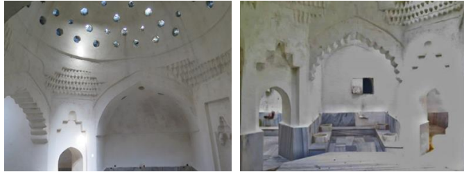
Fig. 19-20. Antalya Nazır Hamamının Sıcaklığının Eyvan Örtüsü ve Halvet Hücreleri Girişleri
