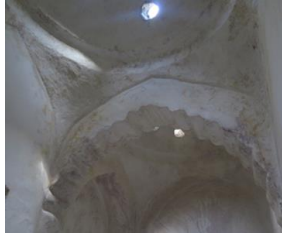
Fig. 12-13. Nazır hamamı Ilıklık Mekanı Orta Kubbe, Yan Kubbe ve Dilimli Kemer
