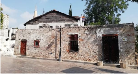
Fig. 1 Antalya Nazır Hamamı Giriş Cephesi
