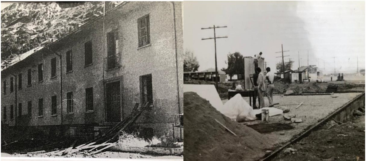
Şekil 8. Eğirdir Kaymakamlık binasının Eğirdir Su Ürünleri Yüksekokuluna tahsisi ve bina bahçesinde dersliklerin inşaatı.
