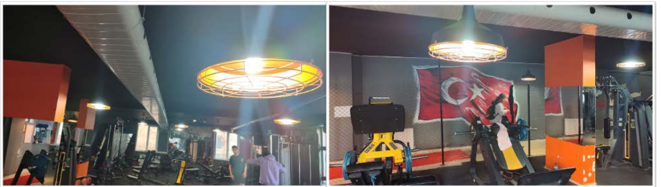
Şekil 14. Işıklandırma ve tavan yapısı.
