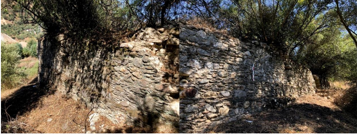
Resim 14: Sailer Bizans askeri yapısı, kuzey duvar görünüm.
