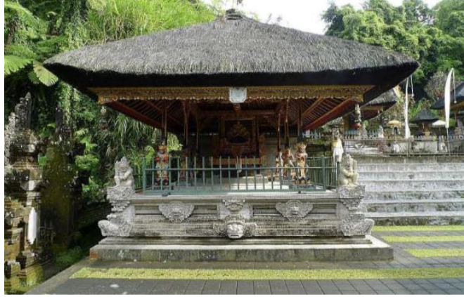
Şekil 20. Palmiye çatının (ijuk) kullanımı (URL 14)
