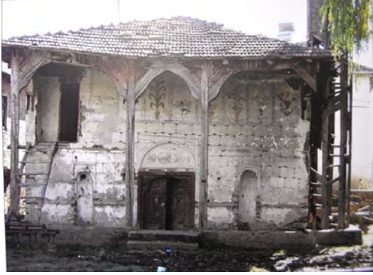
Fig. 22. Eskihişar Köyü Cami onarım öncesi hali (VGM'den).
