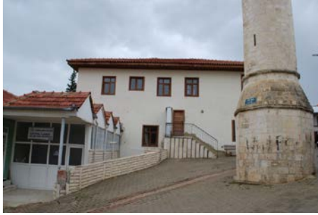
Fig. 8. Kütük Cami doğu cephesi
