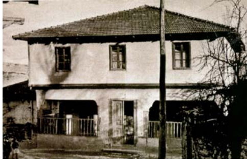
Fig. 10. Kütük Cami kuzey cephe
