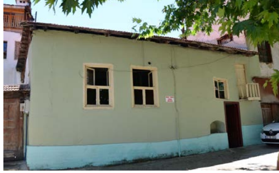
Fig. 2. Tahta Mescid'in doğu cephesinden genel bakış
