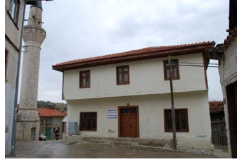
Fig. 11. Kütük Cami kuzey cephesi 2
