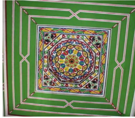
Fig. 19. Köşelerde yer alan tavan uygulaması
