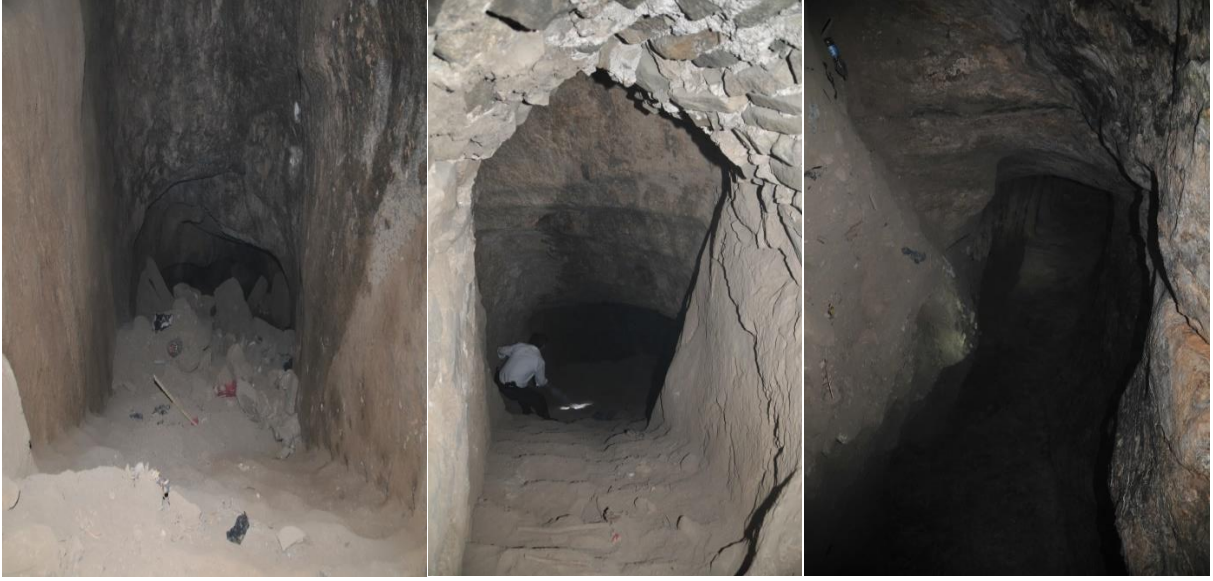
Şekil 43-45. Kale Altı Sarnıcı III Nolu Mekân Merdiven Görünüşleri (Kaynak: Ş. Öztürk, 2015)
