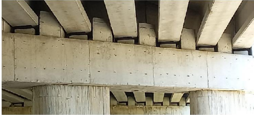
Şekil 5. Elastomer Mesnet Yerleşimi
