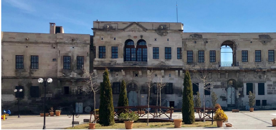
Şekil 3. Tavukçu Mahallesi geleneksel sivil mimari örneği yapılar, Kuyumcuoğlu Konağı (Solda), Camcioğlu Konağı (Ortada), Efendiağalar Konağı (Sağda), 2022
