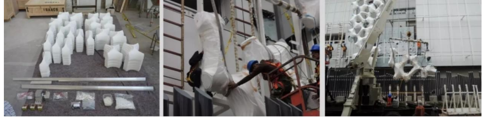
Şekil 39. Malzemenin şantiyeye getirilme ve montajı aşamaları ( http://www.prosolve370e.com/home )
