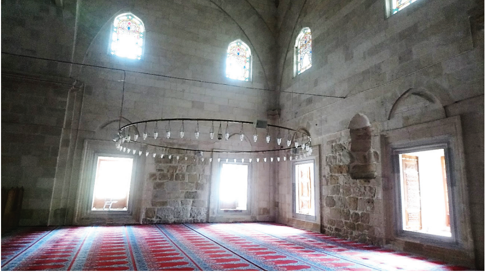
G. 8: Günümüze ulaşmayan hünkâr mahfilinin duvar izleri ve mihrap nişi (N. Ç. Akçıl Harmankaya, 2023)
