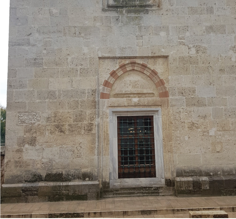
G. 9: Hünkâr mahfilî giriş kapısı olarak kullanılan pencere ve üzerindeki saçak izi (N. Ç. Akçıl Harmankaya, 2022)
