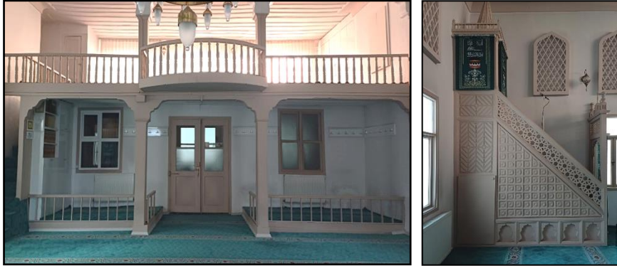
Şekil 31. Çakır Cami Ahşap İç Mekân Detayları (Foto: Keçelioğlu, 2023)
