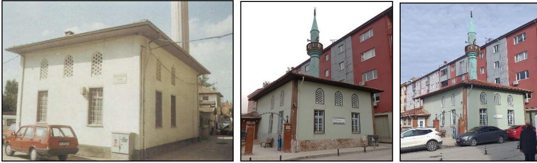
Şekil 32. İnyetullah Cami Görünümü (KTB, 2020; Hakyemez, 2019, s.292; Foto: Keçelioğlu, 2023)
