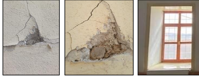
Şekil 7. Cami Duvar Sivasının Altında Görülen Kerpiç Malzeme Örnekleri ve 0.70 m Kalınlığındaki Beden Duvarı (Foto: Keçelioğlu, 2024)
