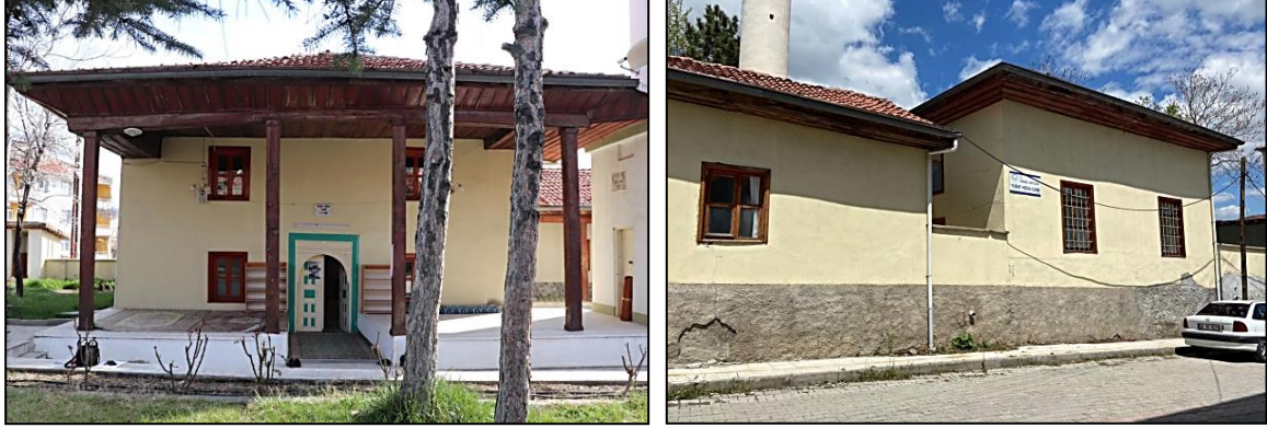
Şekil 20. Hilmi Efendi Cami Kuzey ve Güney Cephe Görünümü (Foto: Keçelioğlu, 2023)
