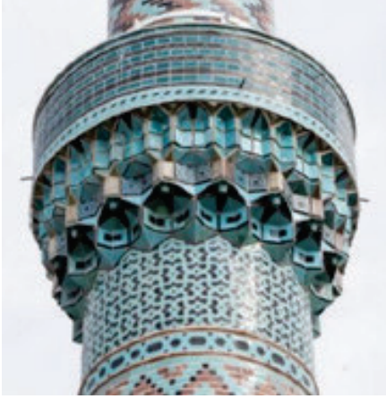
Görsel 4: İznik Yeşil Camii Minaresi (http-2)
