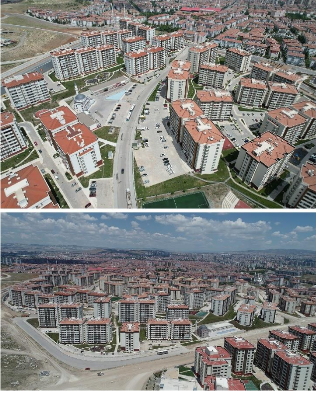
Şekil 5. Kentsel Dönüşüm Sonrası Yapılı Çevre (Sincan Belediyesi, 2020)
