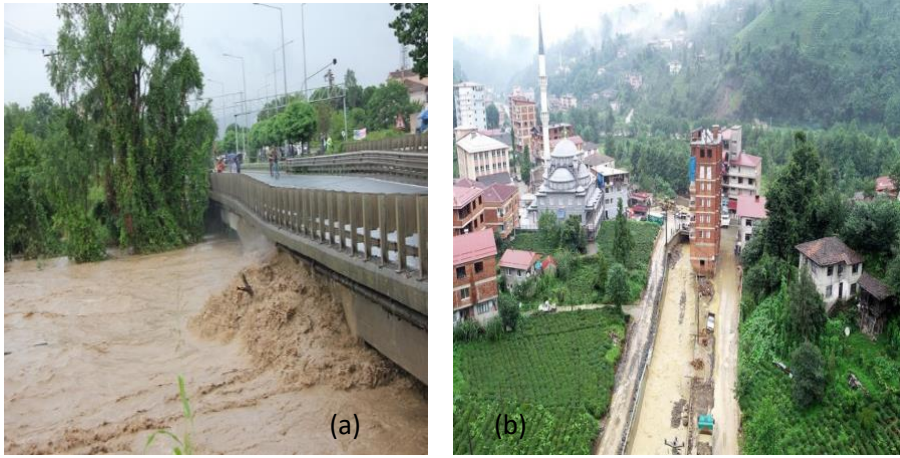
Şekil 6. (a) Ordu’da 2018’deki Sel ve Taşkınlarda Derelerdeki Yetersiz Menfez Genişliği (b) Rize’de 2018’deki Sel Afetinde Dere Yatağında Yapılaşma (Anadolu Ajansı, 2018; CNNTürk, 2018).
